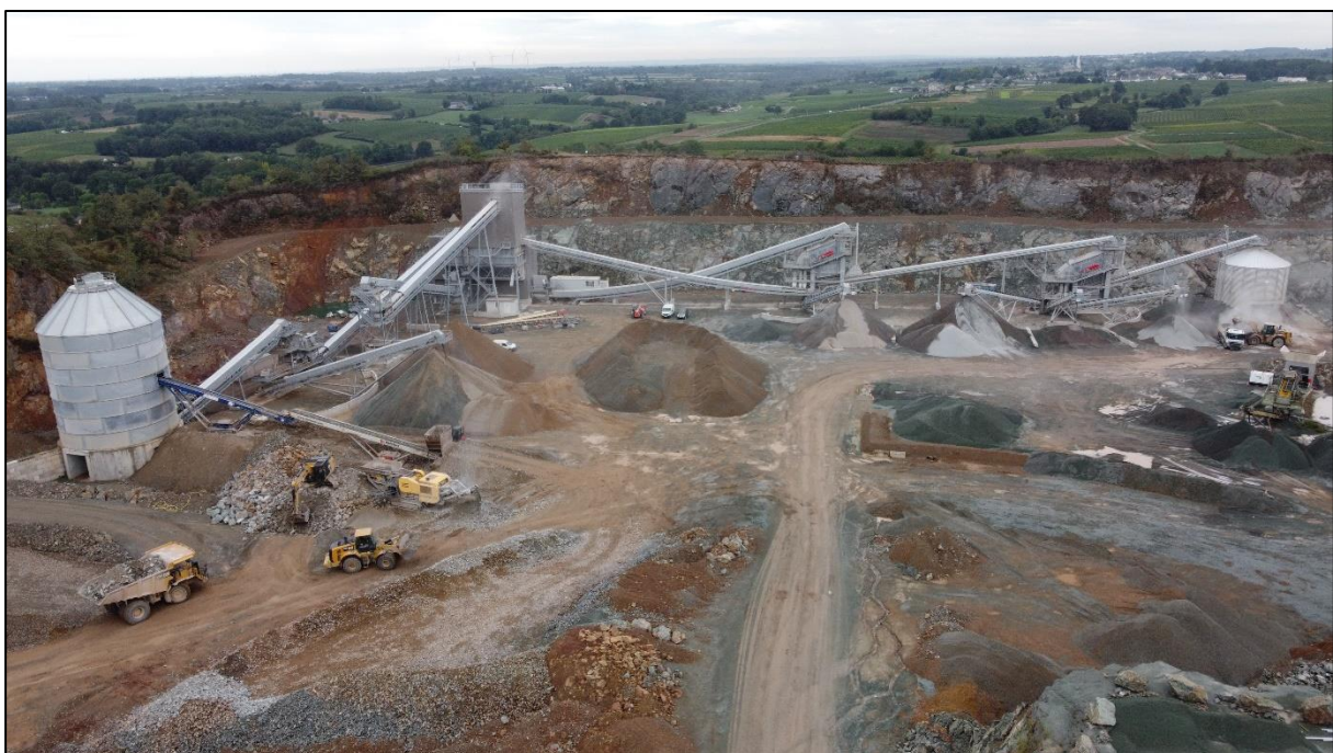
Les installations de traitement secondaire/tertiaire
